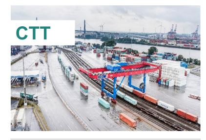
**Anzahl Gleise** 9 **Gleislänge** 720 m **Anzahl Bahnkrane** 4
